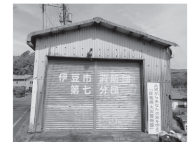
解体される城の消防団詰所
