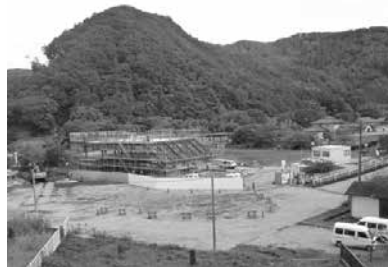
▲市道月ヶ瀬小学校線ができる現場（遠景）
