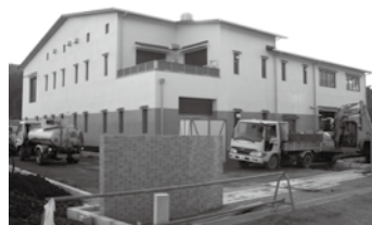
▲完成間近の汚泥再生処理センター
