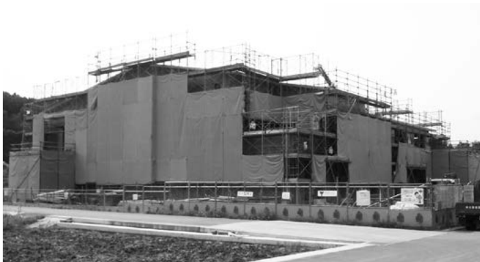
▲建設中の汚泥再生処理センター (田代地区)
