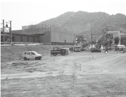
▲整備が進む駅北広場
