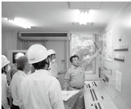
▲中央操作室にて改修工事の説明を受ける(清掃センター)
