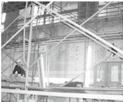
▲伊豆市産の木材壁(中伊豆中学校屋内運動場)
