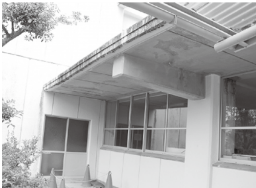
▲天城中学校の技術棟への通路のひさし
