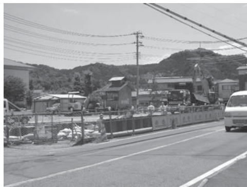
▲中伊豆小学校バス停車帯の完成も間近
