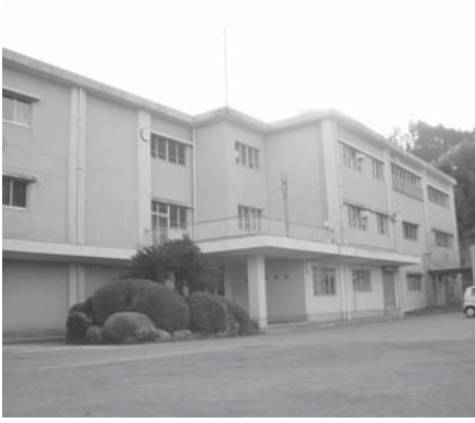
▲狩野小学校（天城湯ヶ島地区青羽根）
