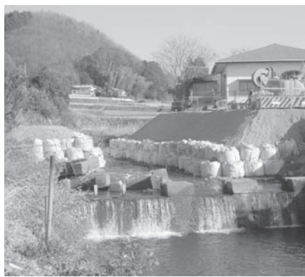
▲西橋新設工事(中伊豆地区下白岩)
