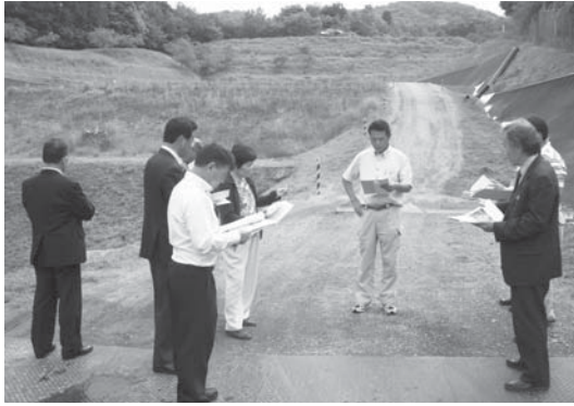
▲本柿木最終処分場
