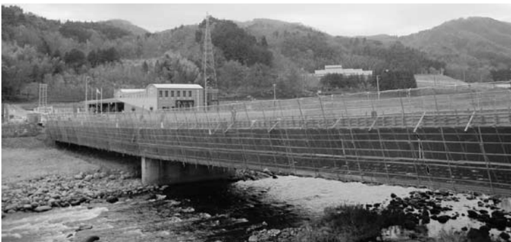
▲春に開通する旭日橋（田方南消防署前）
