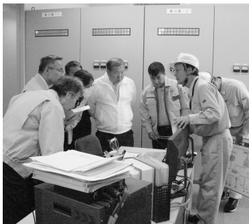
↑バイオマスガス化発電施設
