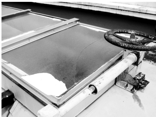
→ガラスの取替え工事が行われる天城温泉プール
