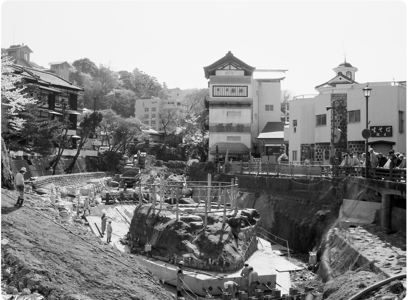
4月4日から修善寺温泉「独鈷の湯」移設工事が行われています。利用再開は、7月の予定です。
