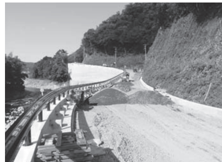
片側通行だった矢熊付近の県道。来年3月完成予定に向け着々と工事が進んでいます。
