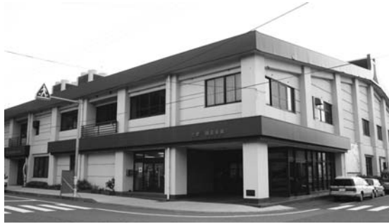
土肥総合会館の外観
