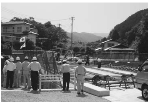
市道柿木線改良工事視察＝柿木橋工事現場で
