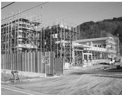
今年4月の供用開始に向け、建設が進む田方消防南署
