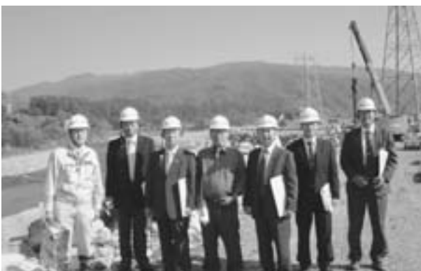
天竜川堤防決壊災害復旧現場
