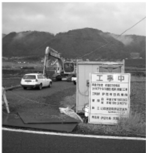
天城北道路大平インターへの連絡道路の橋梁工事が始まりました。
