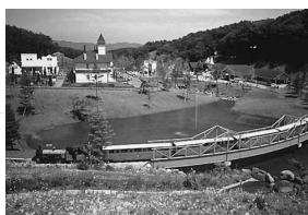
中伊豆温水プール
