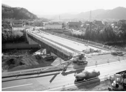
3月開通予定の鮎見橋
