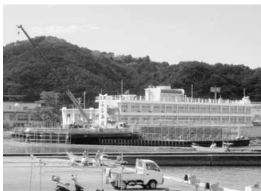
防潮堤工事が進む国民宿舎ふじみ荘付近
