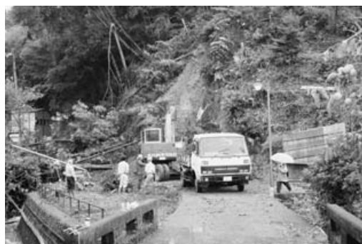
台風 22 号により農協狩野支店裏山の崩落
