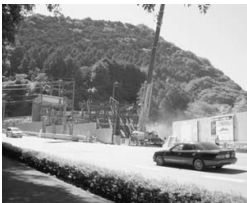
天城北道路立野トンネル工事
