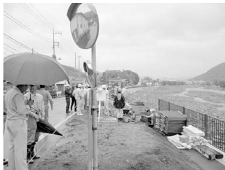
修善寺牧之郷地区、室久土歩道橋工事
