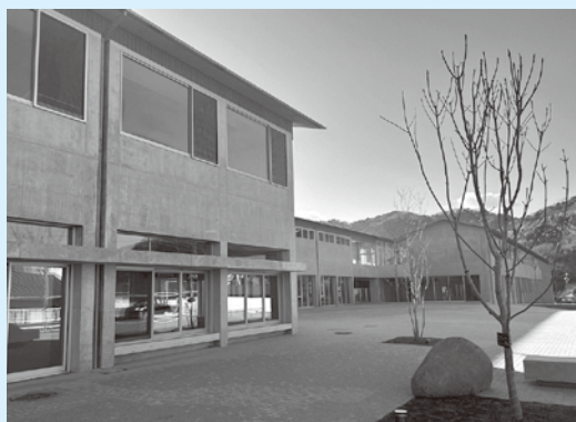
伊豆中学校エントランス付近
