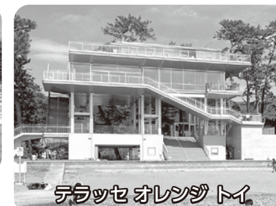
テラス オレンジ トイ ・松原公園津波避難複合施設整備事業 (3億6,016万円) 消防費総額(13億3,419万円)
