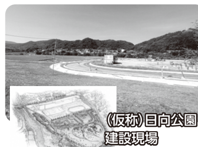
《(仮称)日向公園》 建設現場 ・(仮称)日向公園整備事業 (1億5,353万円) 土木費総額(20億9,377万円)
