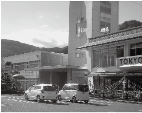
▲天城支所及び天城保健福祉センター
