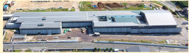
7月下旬、屋根の部分がほぼ完成した校舎 (ドローンによる撮影)
