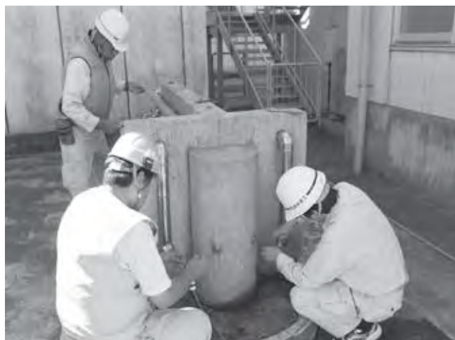
▲水道を点検・修理する市営水道相談センター職員
