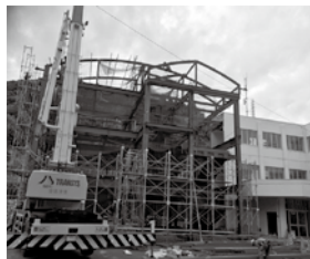
▲改築・改修中の校舎
