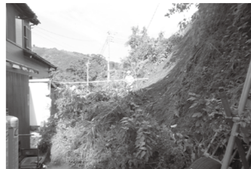
▲市内で起きた土砂災害
