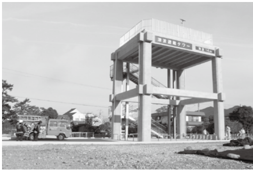
▲八木沢の津波避難タワー
