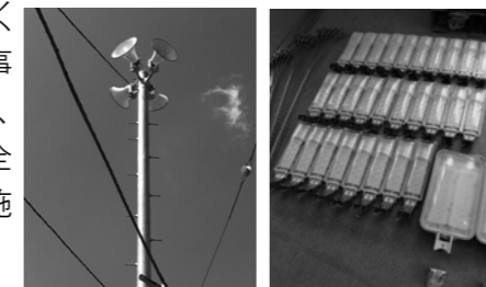
▲平野区に地域コミュニティ用放送設備 ▲下尾野郷LED防犯灯
