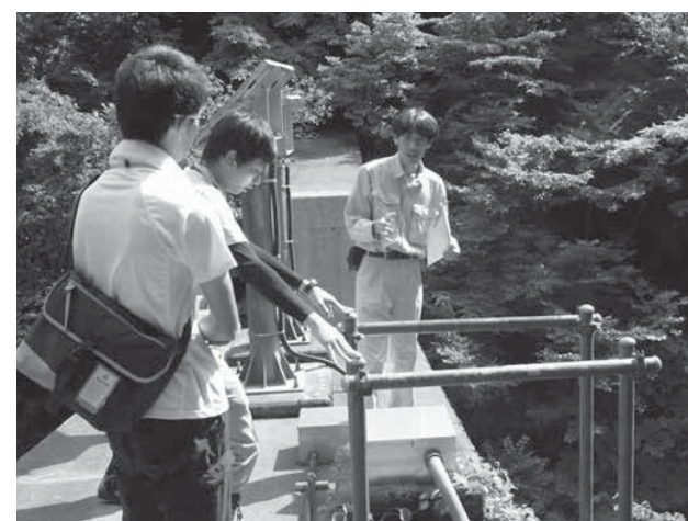
▲砂防えん堤を見学し、説明を受ける大学生
