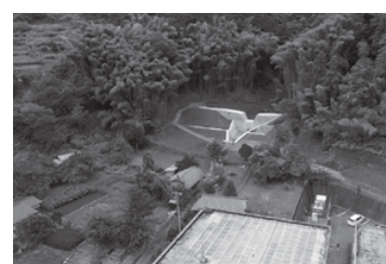
▲今年7月に完成した入の洞砂防えん堤重力式コンクリート砂防えん堤（青羽根地区）
