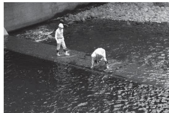
▲砂防施設の点検では、実際に川に入り、施設のひび割れや腐食などの状況を丁寧にチェック
