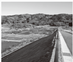
▲完成に向け、工事中
