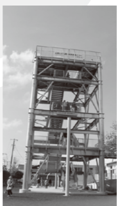
▲土肥の津波避難タワー
