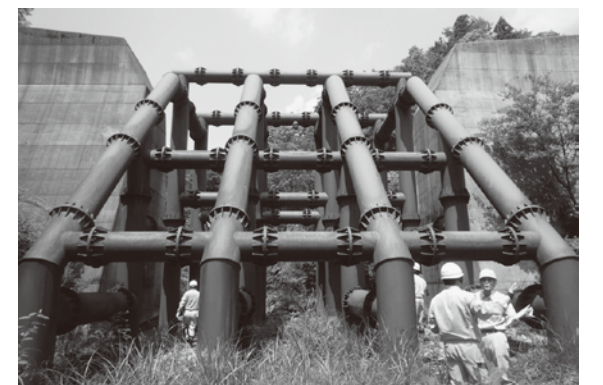
▲流木などをせき止める砂防施設も耐久性や腐食などを点検
