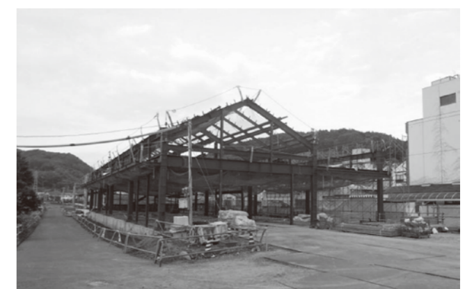
▲現在、工事中の新しい駅舎
