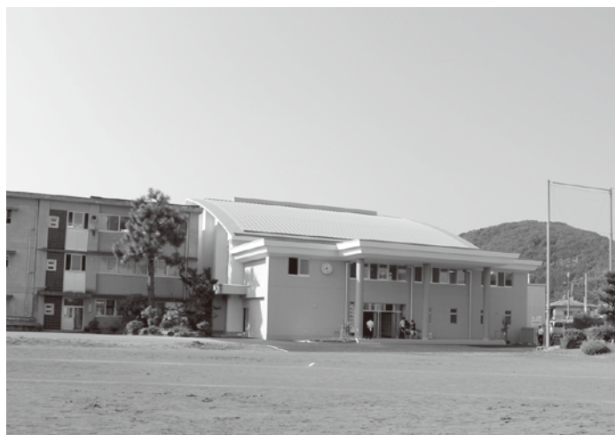
▲屋根と柱には中伊豆中学校のイメージカラーである緑を使用
