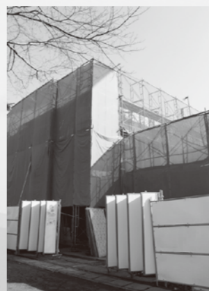
建設中のこども園『あゆのさと』
