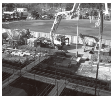
▲冬休み期間中に大きな機械が入り、コンクリート打ちを開始
