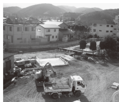
▲用務員住宅と花壇跡地に28台収容の駐車場を造成中(校舎南側)
