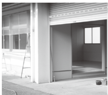
▲旧消防署車庫に建設される待合所
