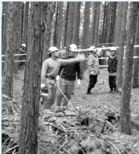
▲間伐作業の片付けの様子
