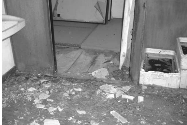
▲窓ガラスが割れ、全ての部屋の畳がカビなどで腐敗している
