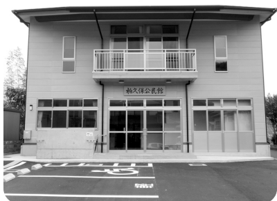
▶完成した柏久保公民館
