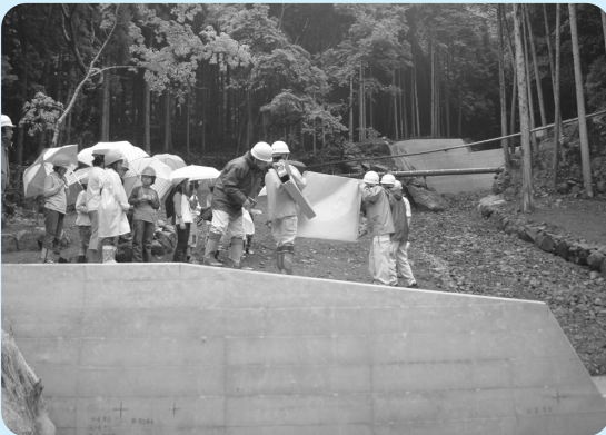
▲天金地区の治山工事の現場を見学
