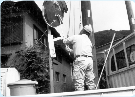
▲洗剤をつけてカーブミラーを磨きました
