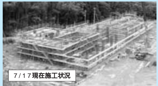
柱鉄筋の組立を実施中
