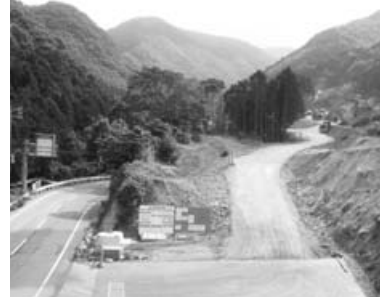
左：国道136号線 右：工事用道路
