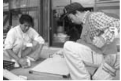
▲トイレのドアを補修（狩野幼稚園）
