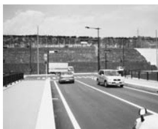
開通した鮎見橋
