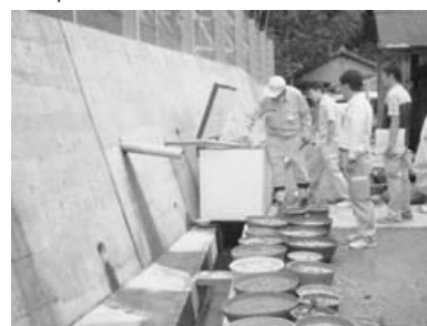
急傾斜地パトロール（裏山の点検）
