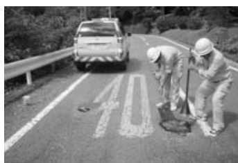
道路パトロール（道路の穴埋め作業）
