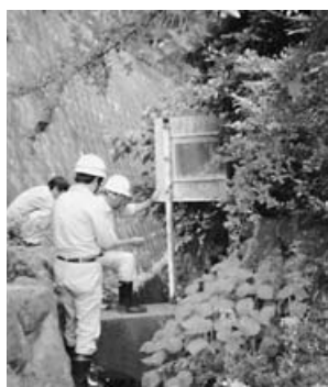
河川パトロール（護岸の点検）
