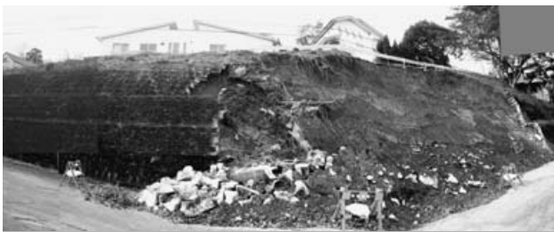
着工前（市道 31438 号線ニュータウン楼湯園付近）
