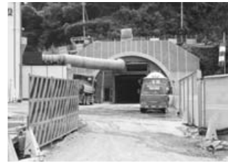
着々と工事の進む本立野トンネル
