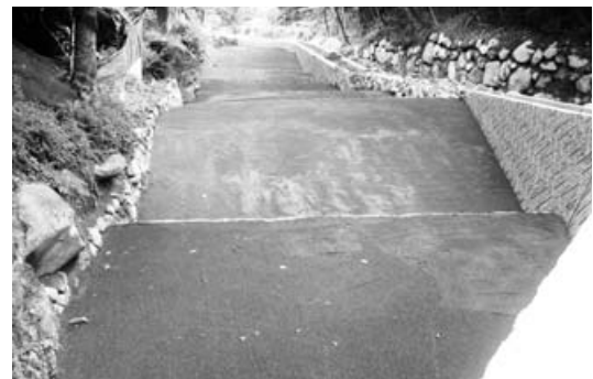
わさび田 復旧工事完成
